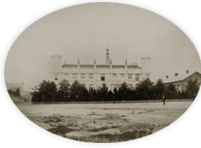
De achtergevel van de HBS met speelplaats in 1876.
